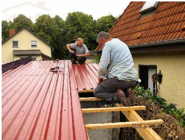
Abbildung 3: Bsp. Verlegung Stahlblechplatte Trapezprofil
