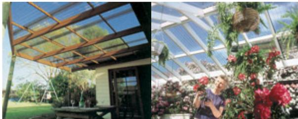
Zuschneiden Wellplatten -Sägen o. Kreissägen mit feiner Zahnung; Bohren mit allen Bohrern- Bohrdurchmesser mindestens 5 mm größer als Schraubendurchmesser (Gewährleistung Materialausdehnung)
